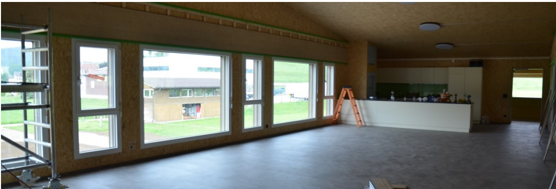
Ausbauarbeiten im Reiterstübli, im Hintergrund die Küche
