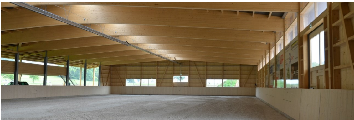
Ansicht in der Reithalle, Tretschicht und Bewässerungsanlage bereits montiert.
